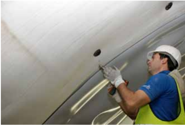
7 Installation der Rondellen Installing the rondelles
