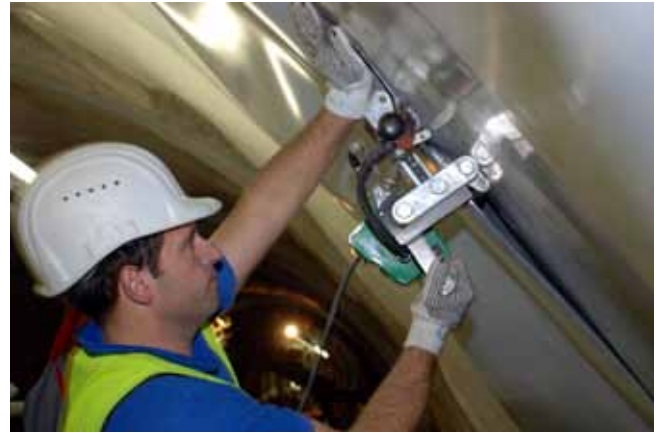
8 Verschweißung der KDB Welding the tunnel waterproofing membrane
