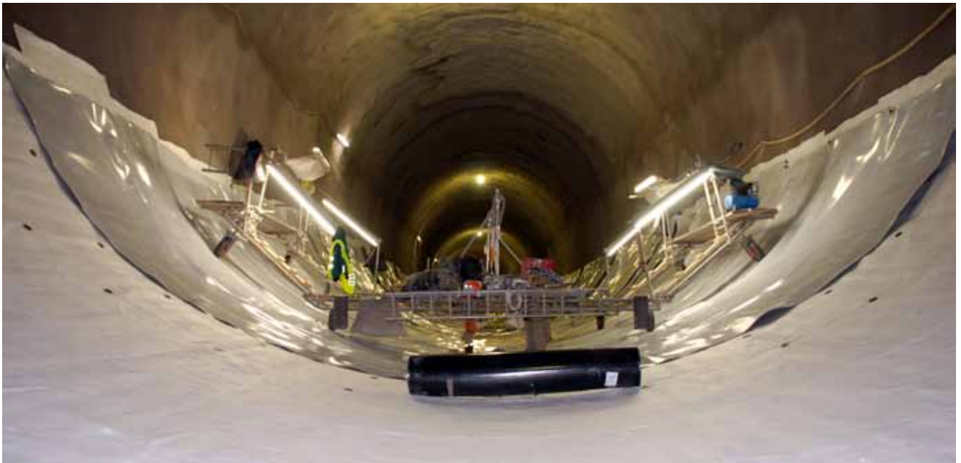
3 Mechanisch verfestigter Vliesstoff als bergseitiges Schutzgeotextil gegen den rauen Spritzbeton
